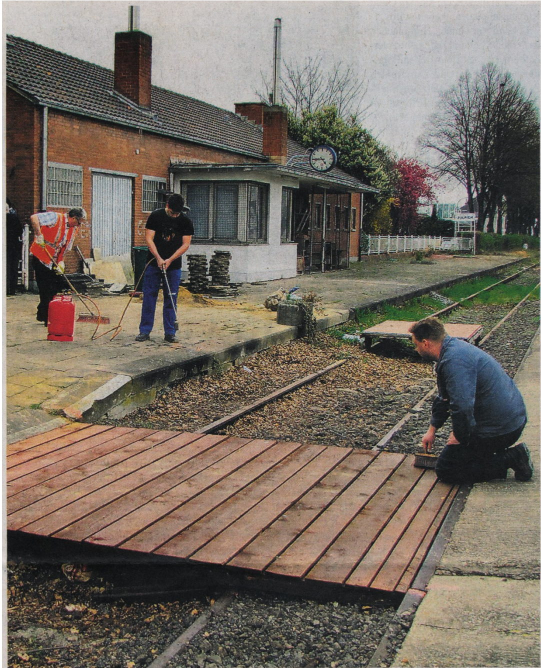
Mit ehrenamtlichen Kräften sind die IG Rurtalbahn und der Verein Bürgerbahn am Bahnhof in Zülpich im Einsatz, um den Bahnsteig barrierefrei und verkehrssicher zu machen.
