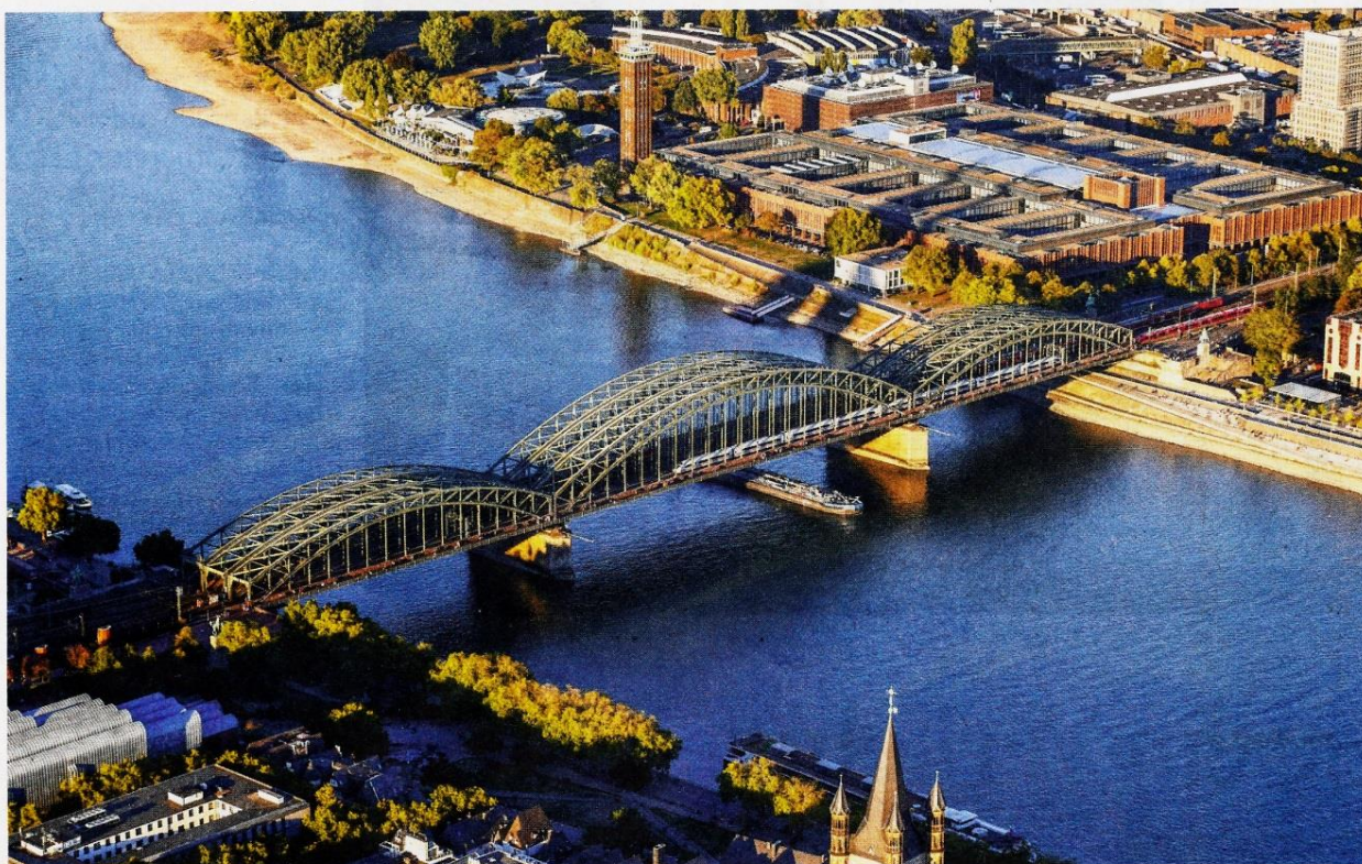
Zwei der sechs Gleise auf der Hohenzollernbrücke sind in den Osterferien wegen Gleisbauarbeiten gesperrt.
