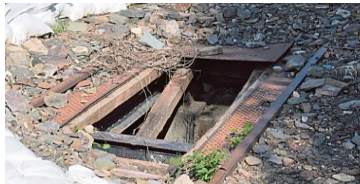
Die Abdeckplatten einer Brücke am Dorfplatz in Olef wurden weggespült. Schotter und Steine liegen auf den Schienen.
